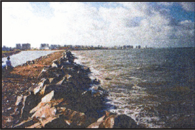
ISL 6 – Encoramento (“rip-rap”) exposto
