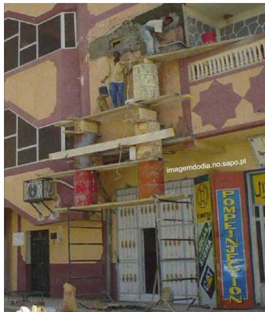
Andaimes totalmente inadequados.
